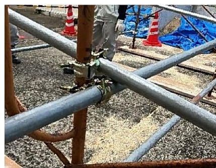
図 11 シーソーの可動部の様子
