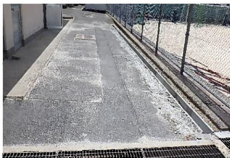
工事着工前の様子
