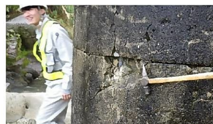
図9 乙姫橋の様子
