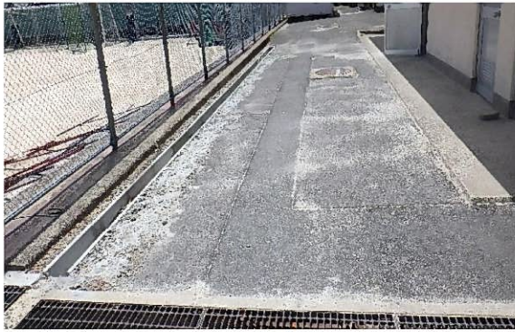
着工前の様子
