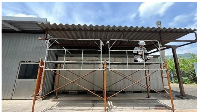
足場組立後の様子→
