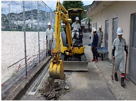
バックホーで剥ぎ取りをしている様子
