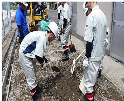
不陸整正を行っている様子
