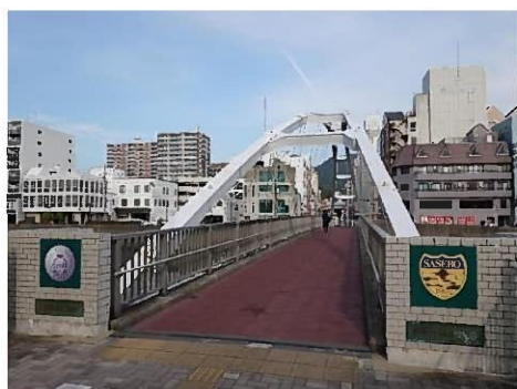
アルバカーキ橋
