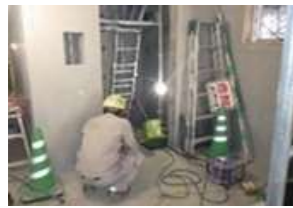
エレベーター工事
