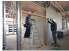
建具枠取り付け
