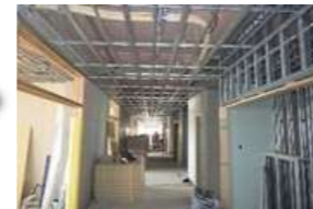
天井下地完了
