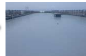
屋上防水完了
