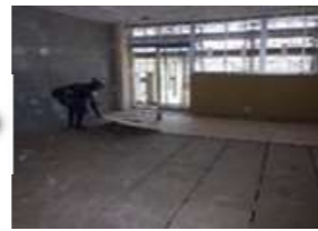
教室床下地工事
