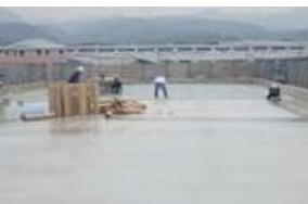
屋上防水施工
