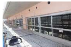
外壁吹き付け塗装完了
