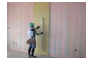
石膏ボード貼り付け
