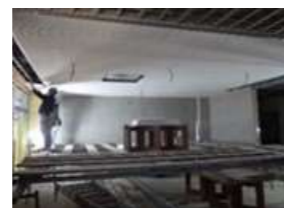
教室天井ボード貼り
