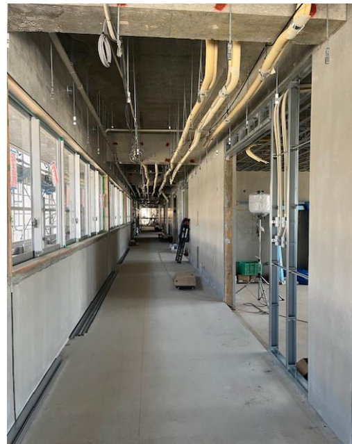
(内装工事の状況)
