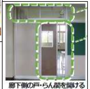
廊下側の戸・らん間を開ける
