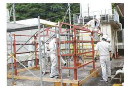
鉄骨小屋組立
