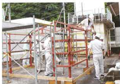
鉄骨小屋組立
