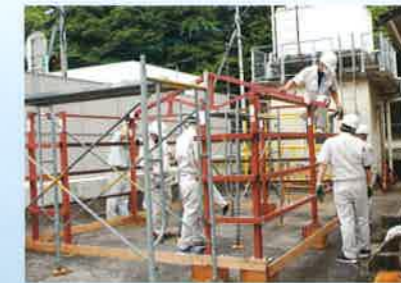
鉄骨小屋組立
