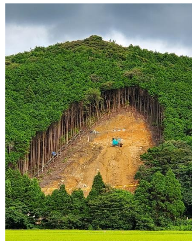
国道384号線沿い地滑り(岐宿町川原)
