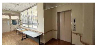
エレベーター
