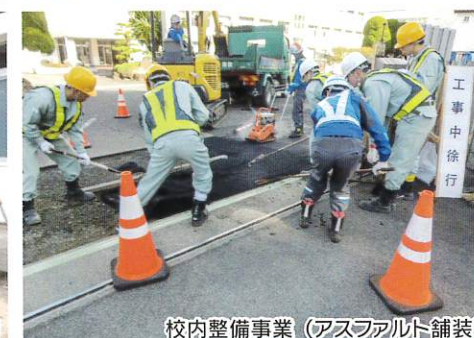
校内整備事業 (アスファルト舗装)
