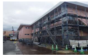
北面足場解体
