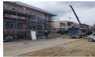
南面足場解体
