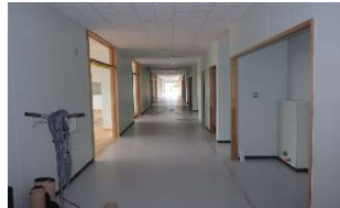
廊下仕上げ完了
