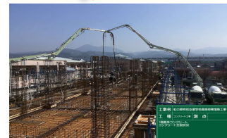
3月16日 2階床コンクリート 流し込み
