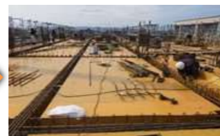
鉄筋組立状況
