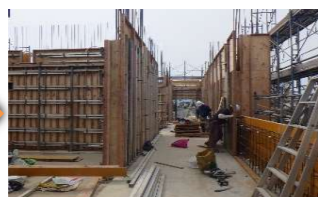
型枠組立状況
