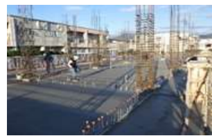
2月16日 1階床コンクリート完了
