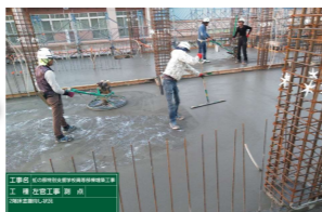
左官による均し作業
