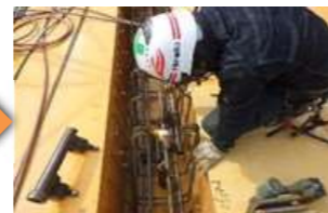
鉄筋圧接状況
