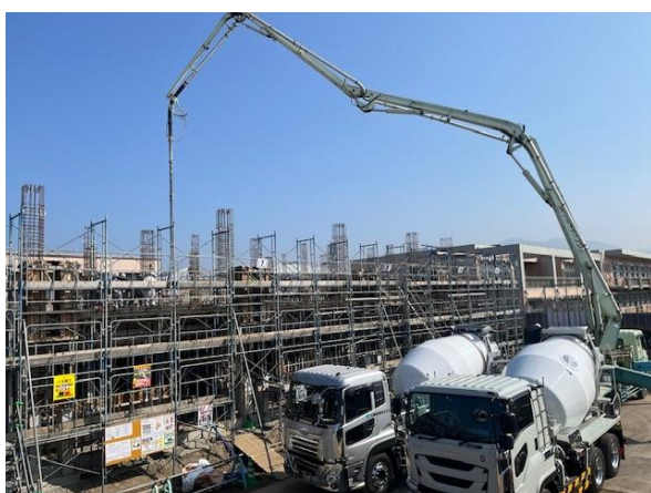
(流し込み作業の様子)
