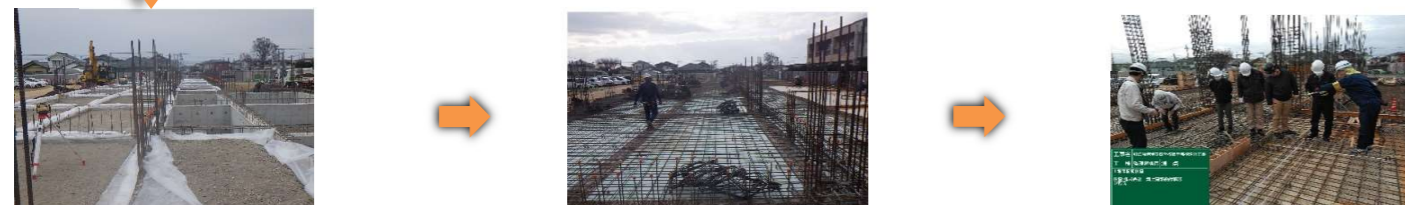
床断熱・床下防湿シート完了 鉄筋組立状況
