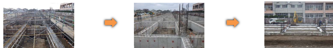
基礎コンクリート完了
