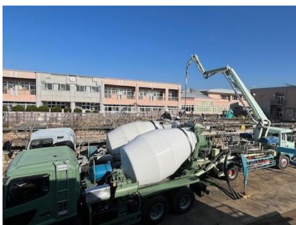
(コンクリート流し込み作業の状況)
